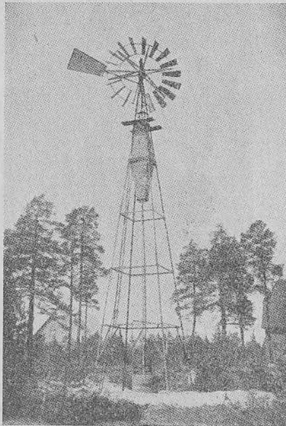
Joon. 61. Tuulemootor D=3 m vesivarustuseks.
